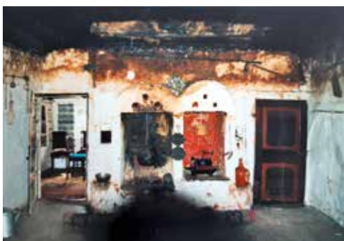
Innenaufnahme mit Blick auf das Kammerfach und den Doppelschwibbogen
